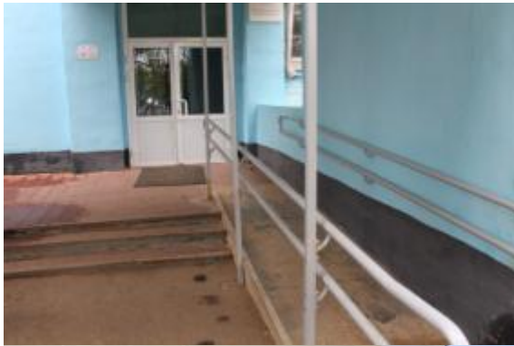
Пандус при входе в школу
